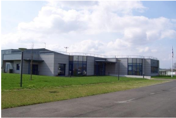
Accueil – Façade Avant
