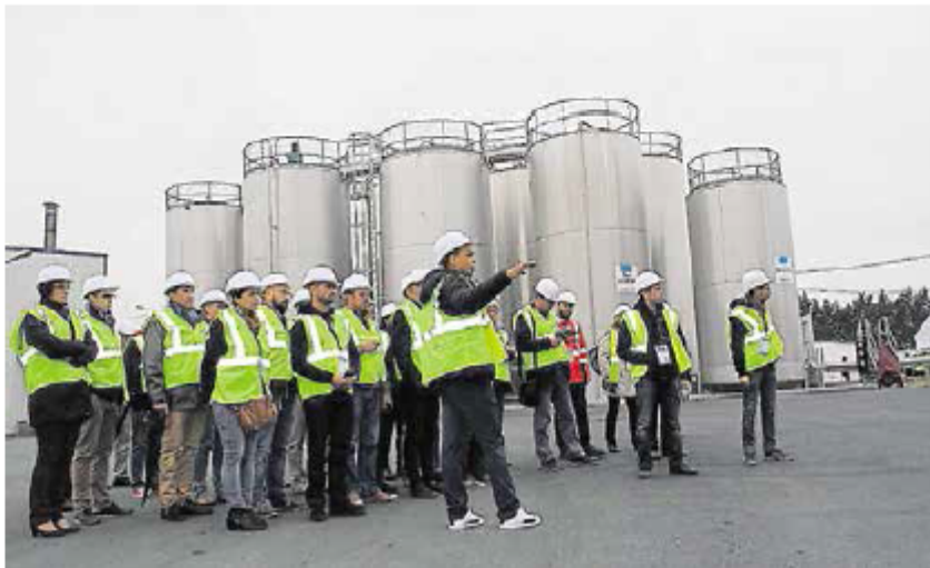
Vendredi, Antipol recevait des partenaires, des clients et des fournisseurs. En arrière-plan, l'installation d'évaporateurs sous vide, décanteurs centrifuges, un atelier de neutralisation, coagulation, floculation et déshydratation.
